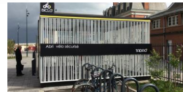
Abris collectif accessible par badge
