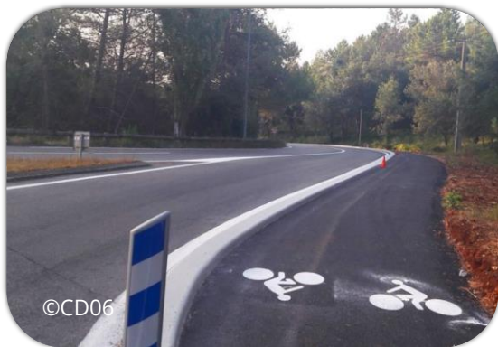
Création d'une piste cyclable le long d'une départementale
