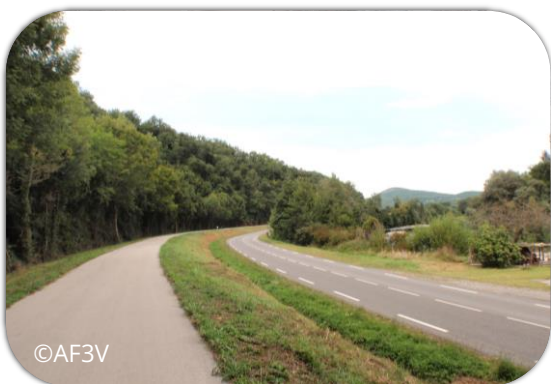
Voie verte en milieu rural, sur l'emprise d'une ancienne voie ferrée
