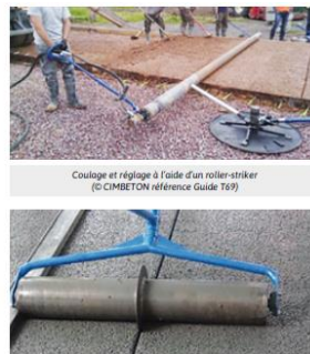
Coulage et réglage à l'aide d'un roller-striker (© CIMBETON référence Guide T69)
